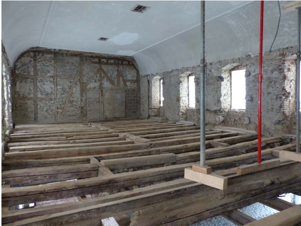
Der freigelegte historische Holzboden in der ehemaligen Turnhalle der JVA
