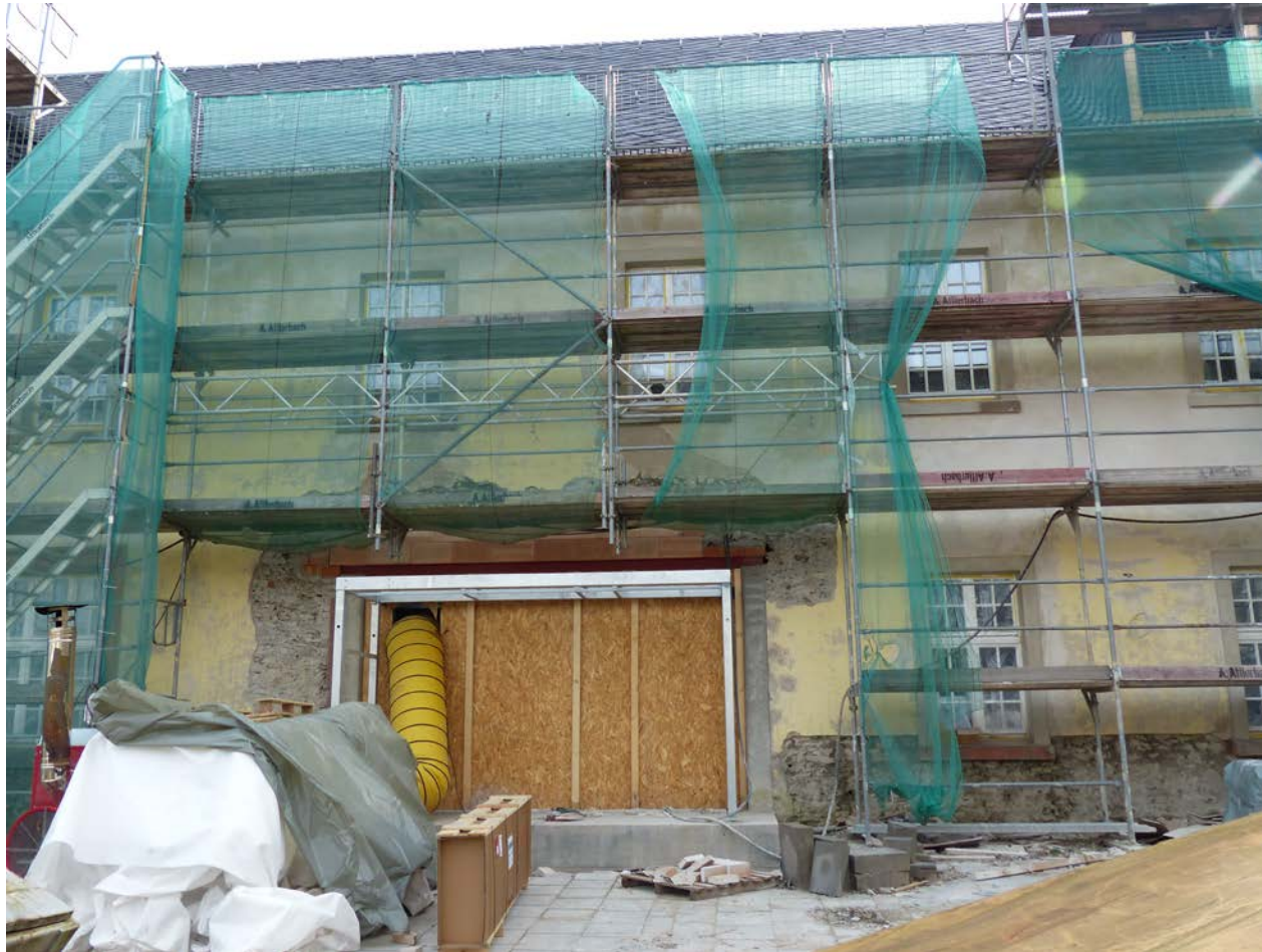
Der Eingang der Bibliothek während der Umbauphase
