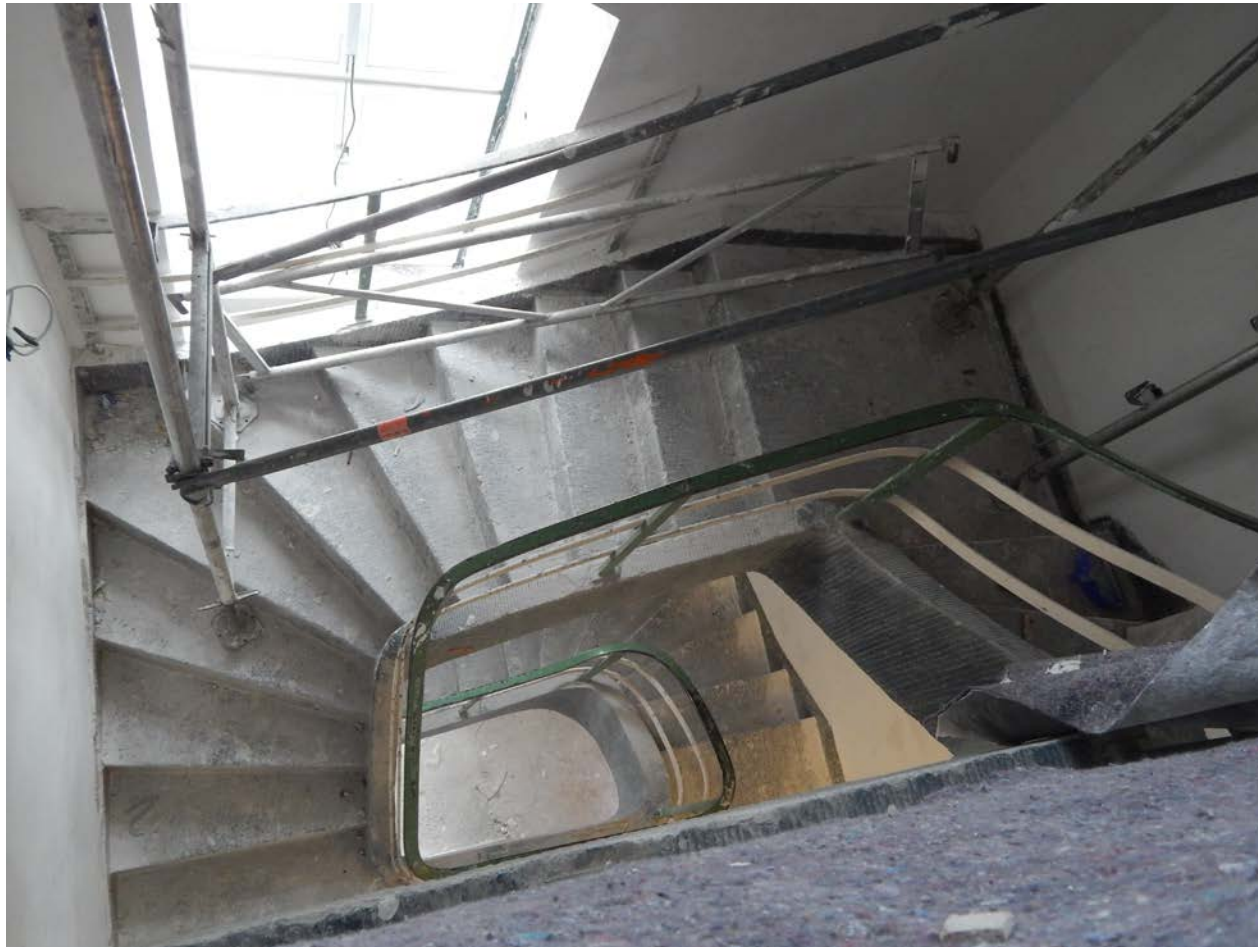
Das historische Treppenhaus während der Umbauphase
