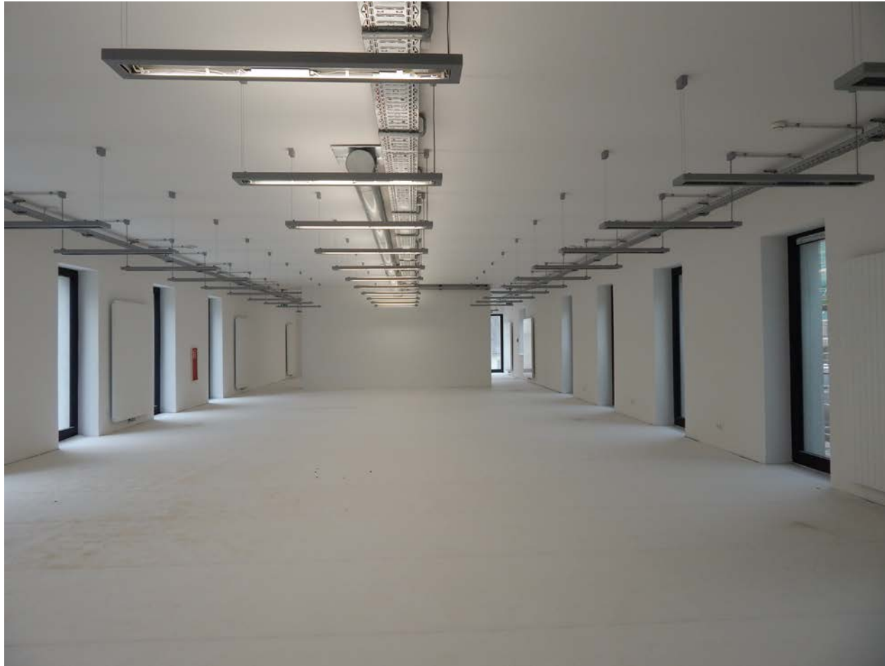
Eine der fast fertig renovierten Medienstellflächen
