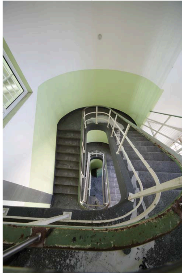
Historisches Treppenhaus zu JVA-Zeiten
