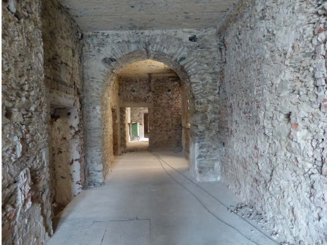
Das freigelegte Mauerwerk mit dem Torbogen im Bereich der PC-Arbeitsplätze
