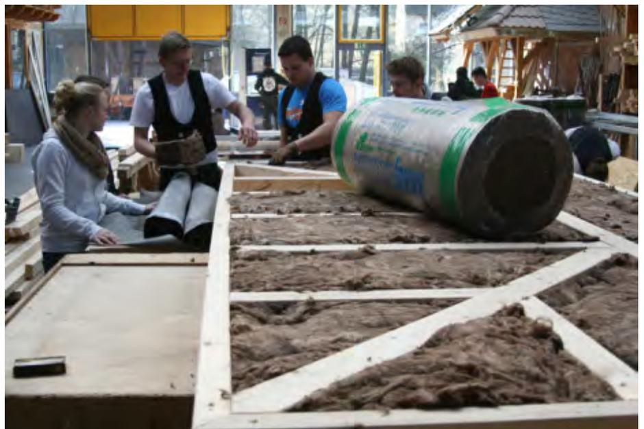
terstützung der Auszubildenden mit den Materialitäten und dem Aufbau auseinander. Neben der Primärkonstruktion in Holz, musste der gesamte Fassadenaufbau berücksichtigt und auch die Mobilität des Baukörpers geplant werden. Schließlich musste er noch an seinen Bestimmungsort transportiert werden. Zum ersten Mal kam auch Stahlbeton als Material für die Fertigteilfundamente zum Einsatz.
